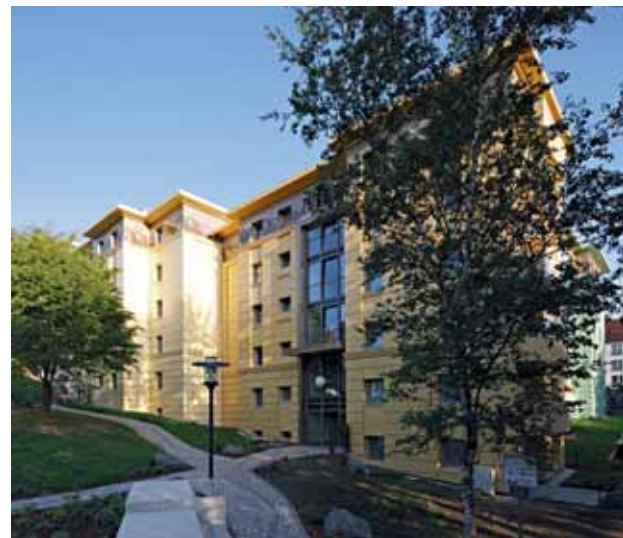
Schönes Haus, schöne Außenanlagen: Die Höxterstraße wird zum Wohlfühlquartier. Das Haus Nr. 4 nach der Modernisierung.
